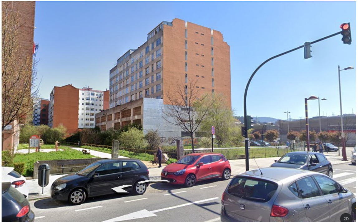
Imaxe na que se ve o corpo da edificación que se pretende cortar e as medianeiras existentes que se pretenden tapar (fonte Street View)
