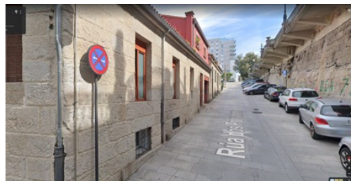
Imaxe 5. Sección actual da Rúa dos Poboadores no seu treito de Conexión coa Rúa de Elduayen
