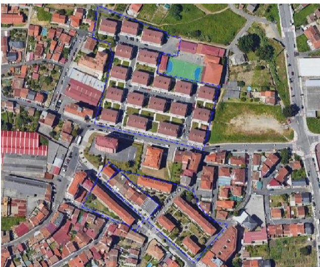
ERRP “Españero-Teis”. Rehabilitación edificatoria.
