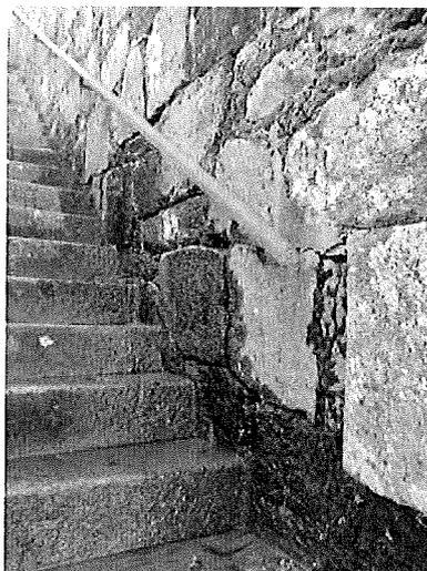
Auga procedente do subsolo saíndo a través dos muros de contención de terras.
