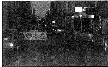
Señalización de obra, señales NO Reflectantes
