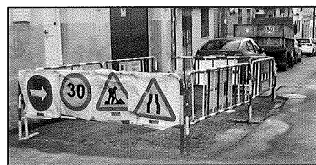
Vallado y señalización de zona de trabajo
