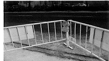
Luz Ámbar intermitente, ubicada de forma INCORRECTA ya que está en el interior
