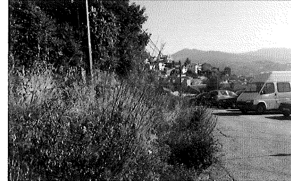
FOTO 10.- Estado actual cunetas en margen impar
