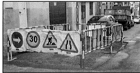
Vallado y señalización de zona de trabajo
