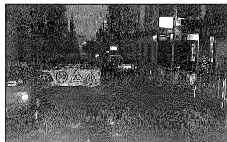
Señalización de obra, señales NO Reflectantes
