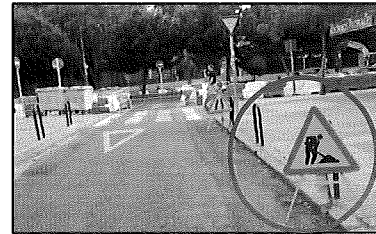
Señal de "Peligro Obras" en la calzada
