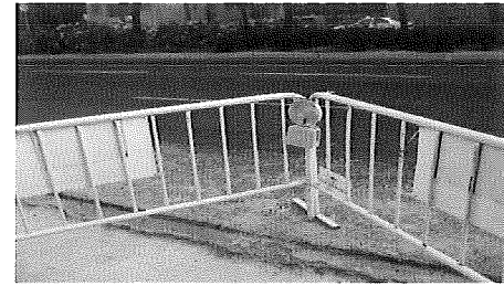
Luz Ámbar intermitente, ubicada de forma INCORRECTA ya que está en el interior
