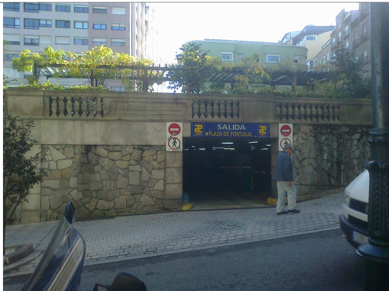
FOTO Nº4: Saída de vehículos cara á rúa República Argentina, dende o nivel -1.
