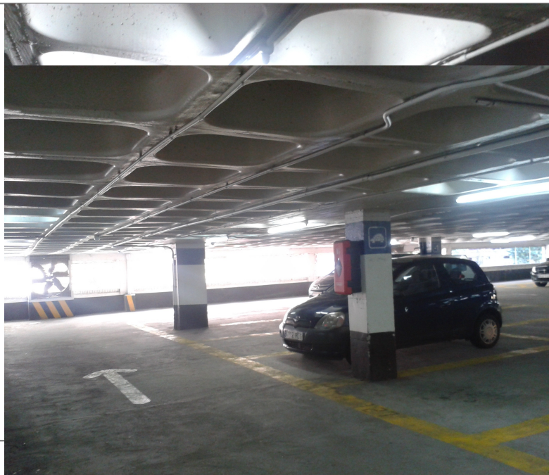
FOTO Nº6: Rúas de circulación na planta -2.
