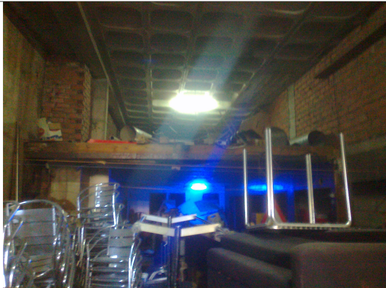
FOTO Nº11: Local contiguo ó actual aparcamento, no que se plantexa a posible saída de emerxencia das dúas plantas e a construción da escaleira exterior de comunicación entre a Praza de Portugal e a Rúa Uruguay.
