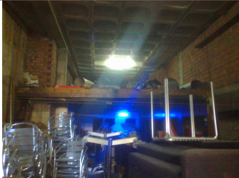
FOTO N°11: Local contiguo al actual aparcamiento, en el que se plantea la posible salida de emergencia de las dos plantas y la construcción de la escalera exterior de comunicación entre la Plaza de Portugal y la Calle Uruguay.
