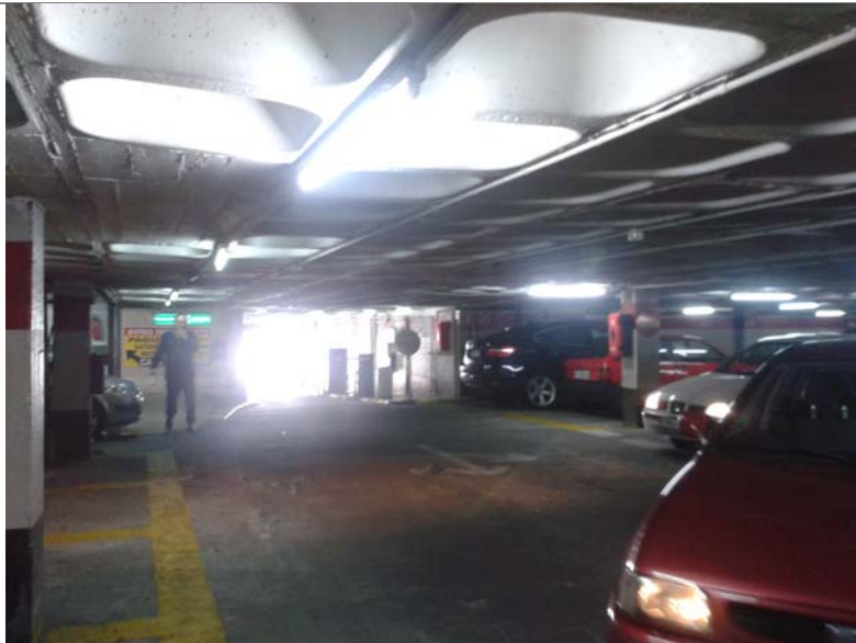
FOTO N°6: Calles de circulación en la planta -2.
