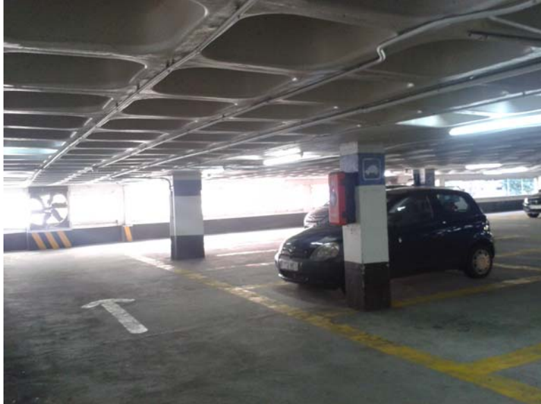
FOTO Nº7: Calles de circulación e iluminación y ventilación natural en la planta -1.
