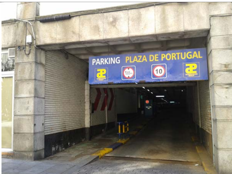
FOTO N°2: Acceso vehículos y peatones en el nivel Sótano -2, C/ Uruguay
