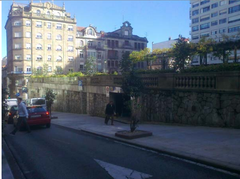
FOTO N°5: Fachada hacia la calle República Argentina.
