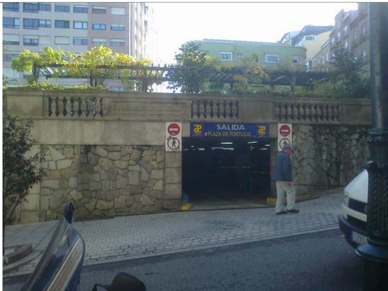
FOTO Nº4: Salida de vehículos hacia la calle República Argentina, desde el nivel -1.
