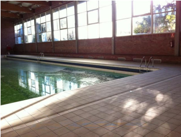
Estado actual de la piscina
