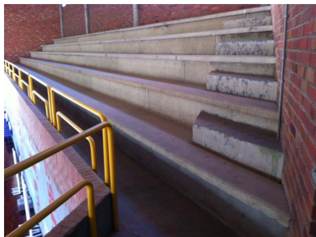
Estado actual de las gradas (sin acceso)
