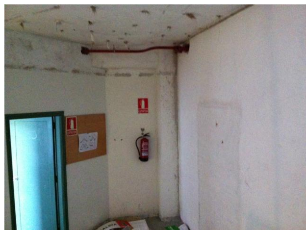
Zona de apertura de puerta para comunicar con el actual receptor del pabellón actual.
