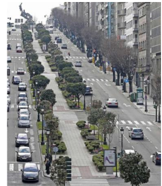
• EJE GRAN VÍA. Desnivel superior al 9%
