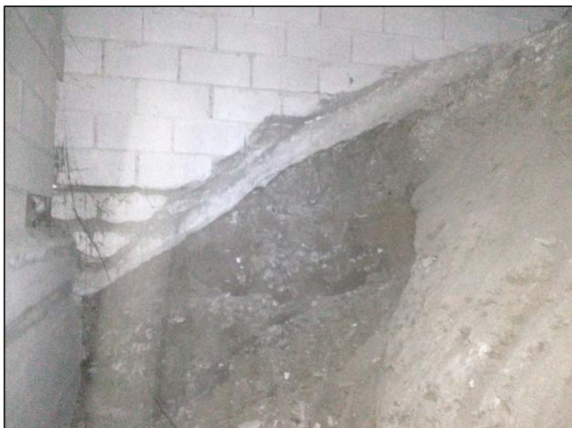
**Vista del relleno existente bajo el forjado de la pista del pabellón.**
