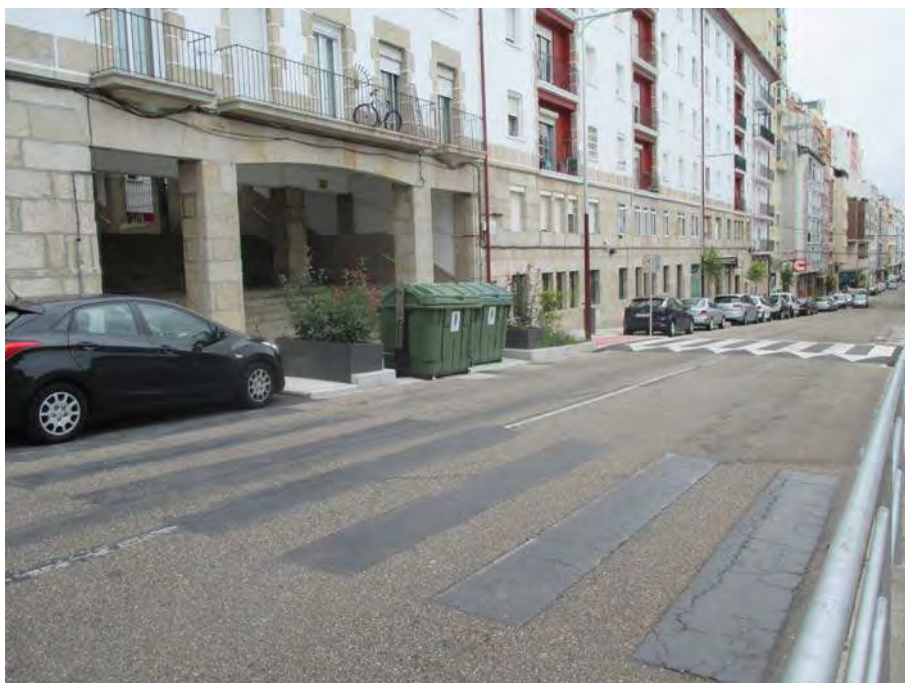
Ilustración 13: Jardinerías en contenedores ejecutados en la fase I de urbanización
