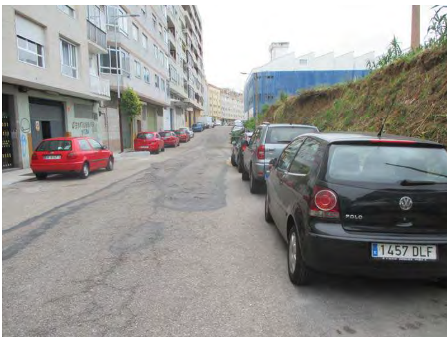
Ilustración 9: Firme deteriorado en la calle Marqués de Valterra
