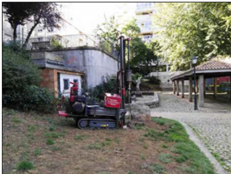
Vista del equipo de penetración dinámica en el punto P-3.
