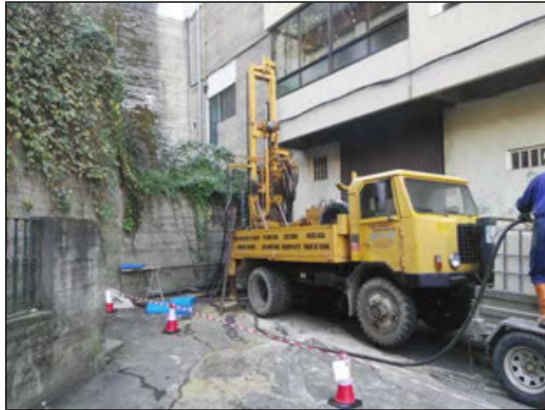
Equipo de sondeos en el punto S-2.
