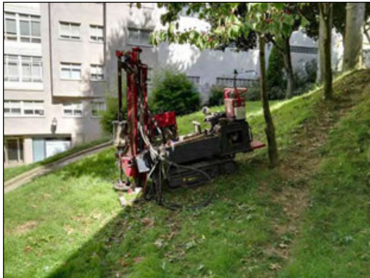
Vista del equipo de penetración dinámica en el punto P-6.
