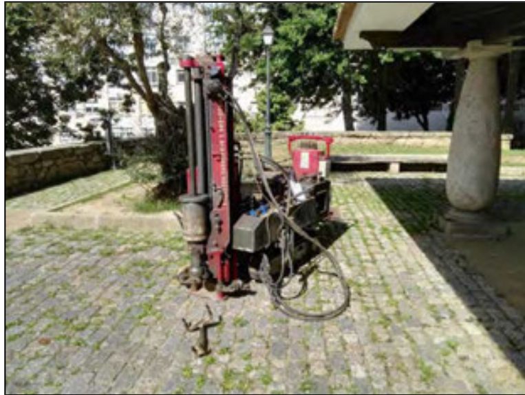
Vista del equipo de penetración dinámica en el punto P-5.
