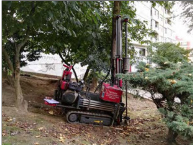
Vista del equipo de penetración dinámica en el punto P-1.
