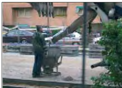
Utilización de cubos para vertido: precaución durante su elevación y recepción.
