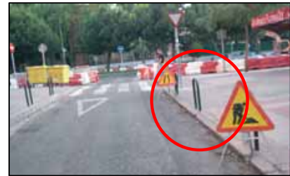
Señal de "Peligro Obras" en la calzada
