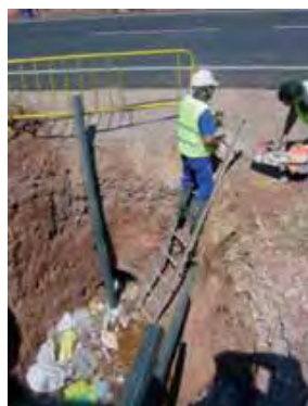
Acceso a zanja mediante escaleras
