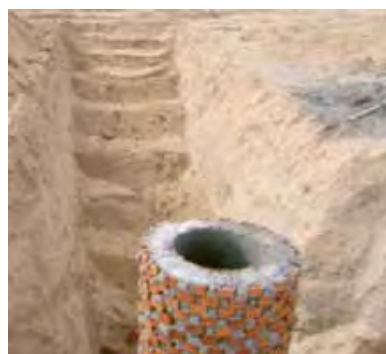
Acceso a zanjas mediante escalera realizada en el propio terreno
