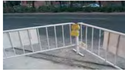
Luz Ámbar intermitente, ubicada de forma INCORRECTA ya que está en el interior
