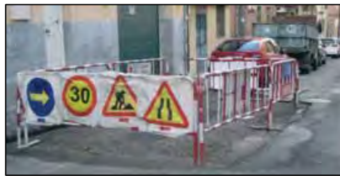
Vallado y señalización de zona de trabajo
