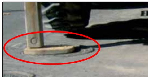
Apoyo del estabilizador de la retro-pala en una arqueta de registro.
