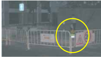
Luz Ámbar intermitente, ubicada en el Ángulo saliente. CORRECTO
