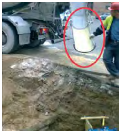
Precaución con el despliegue de la canaleta; asir desde la zona establecida para ello.
