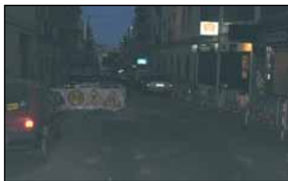
Señalización de obra, señales NO Reflectantes
