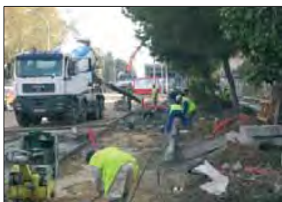
Vertido de hormigón con canaleta.
