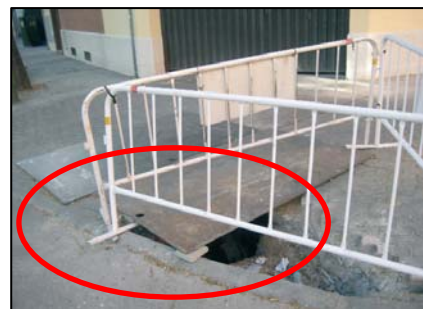
Apoyo inestable de la chapa
