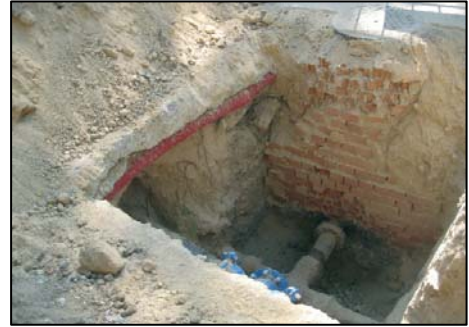
Acopio en borde de la zanja, provocando una sobrecarga estática.
