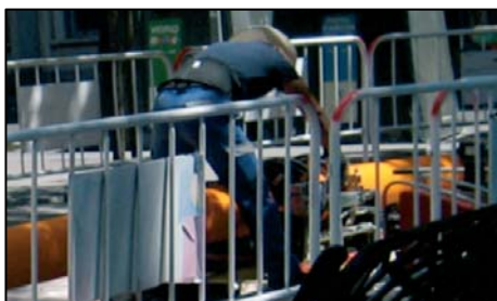
Trabajo de unión entre tramos de conductos realizado desde el exterior, evitando permanecer en la zanja y pudiendo reducir su anchura.
