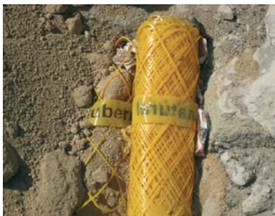
Cinta de señalización de gas
