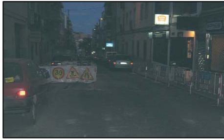
Señalización de obra, señales NO Reflectantes
