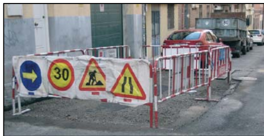
Vallado y señalización de zona de trabajo
