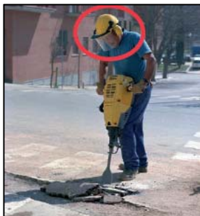
Utilización correcta de pantalla de protección durante operaciones demolición con medios mecánicos.
