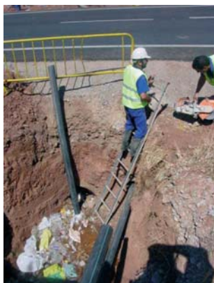
Acceso a zanja mediante escaleras
