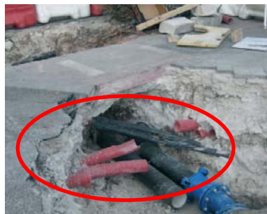
Rotura de los conductos de protección
