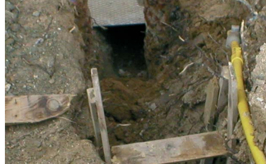
Solución incorrecta e improvisada que no otorga ninguna garantía. El personal que lo realice debe Disponer de formación y experiencia contrastada.
