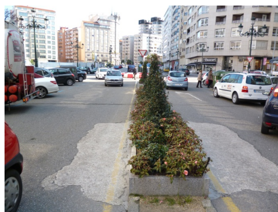
Deterioro de pavimento en zonas de modernización mediana
