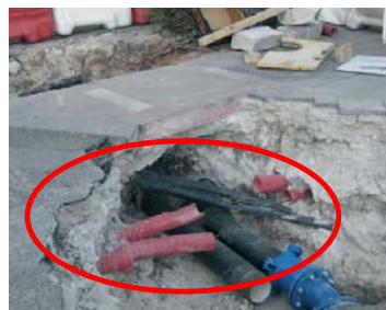
Rotura de los conductos de protección
