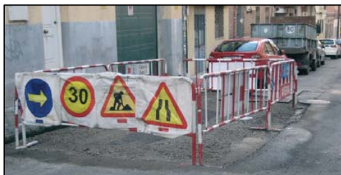
Vallado y señalización de zona de trabajo
