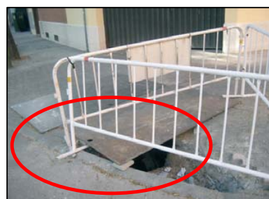
Apoyo inestable de la chapa
