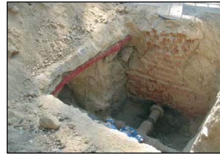
Acopio en borde de la cala, provocando una sobrecarga estática.
