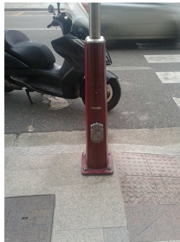
ESCUDO FUNDICIÓN DE ALUMINIO EN LA BASE
