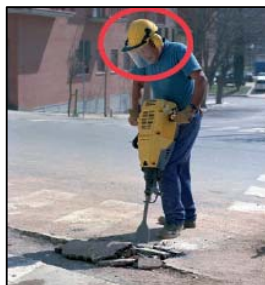
Utilización correcta de pantalla de protección durante operaciones demolición con medios mecánicos.
