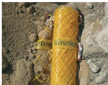
Cinta de señalización de gas
