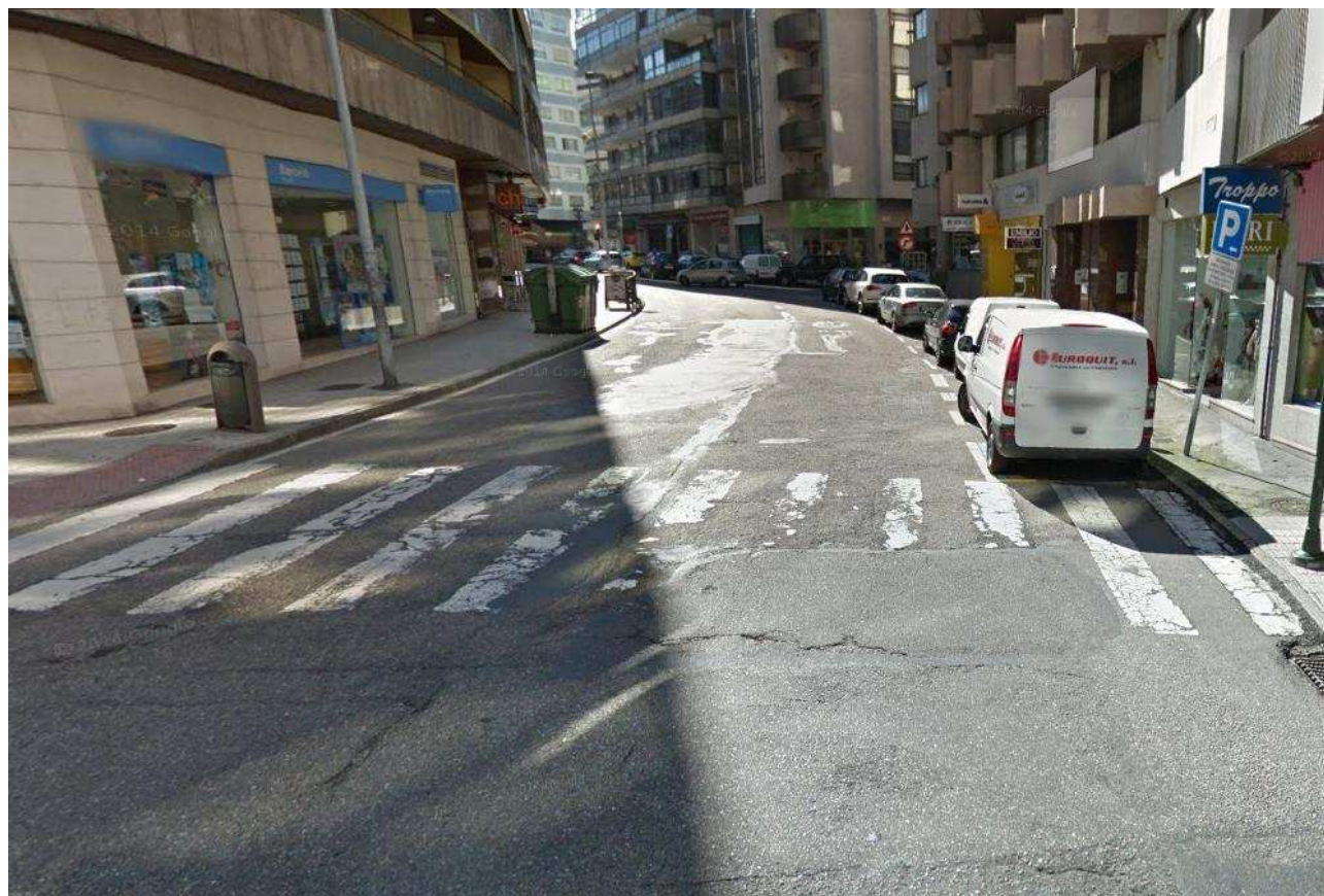
Rúa Álvaro Cunqueiro. Foto nº2. Grietas transversales y descarnaduras
