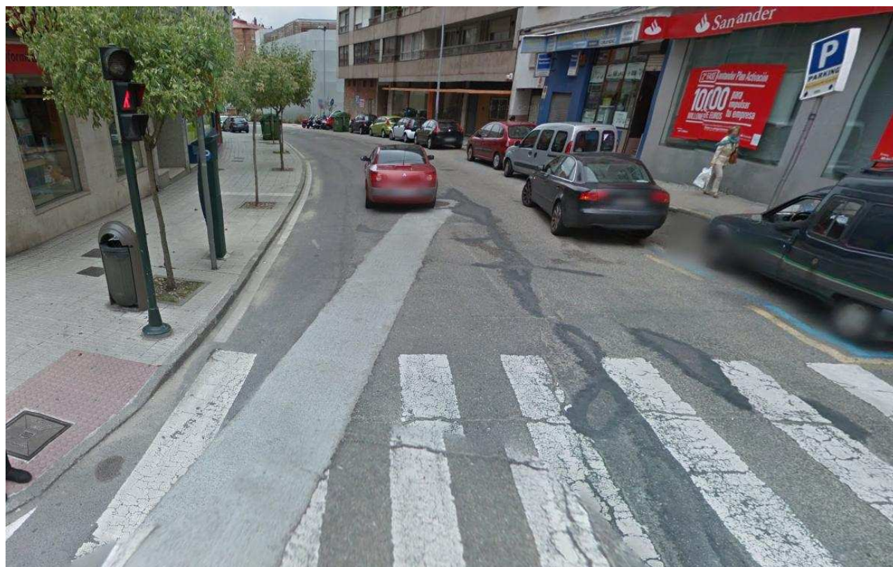
Rúa Álvaro Cunqueiro. Foto nº1. Grietas transversales y descarnaduras
