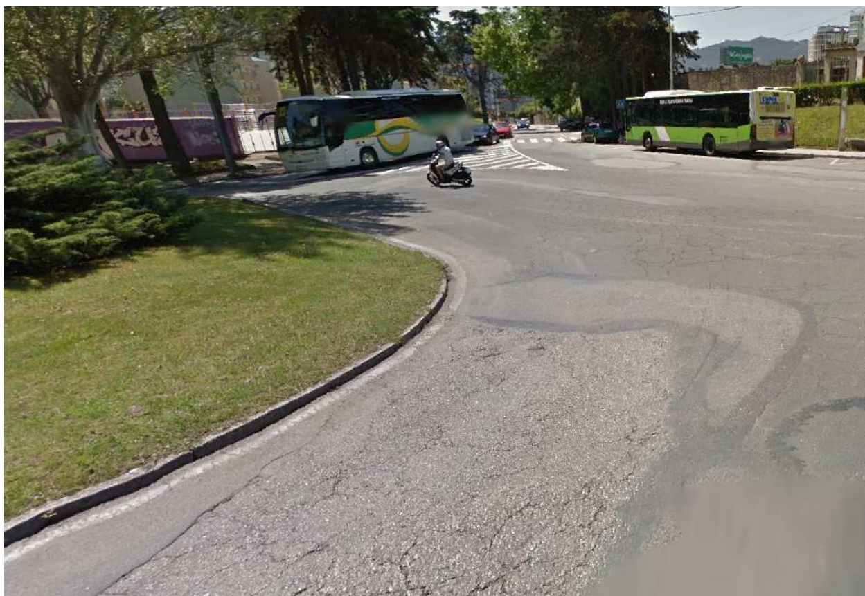
Rúa Cañiza. Foto nº1. Grietas y descarnaduras
