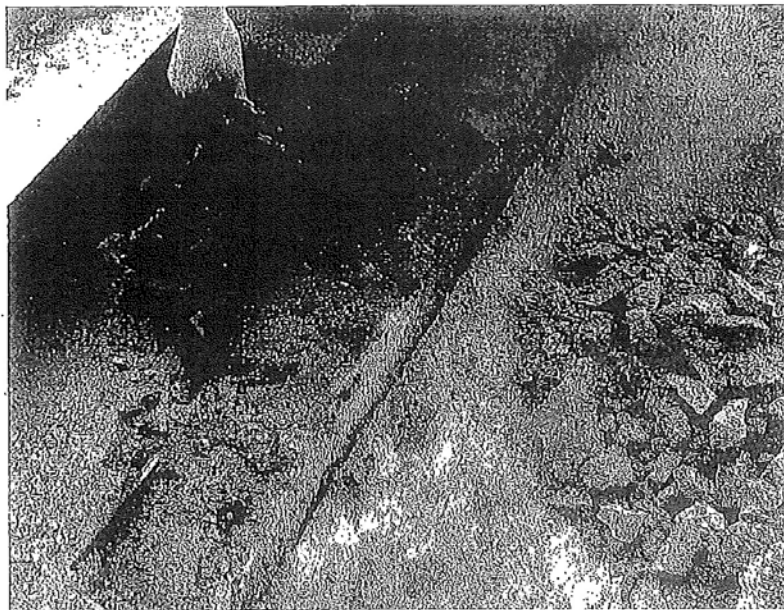
F01 Agua por debajo de la impermeabilización en la parte superior de la junta de dilatación
