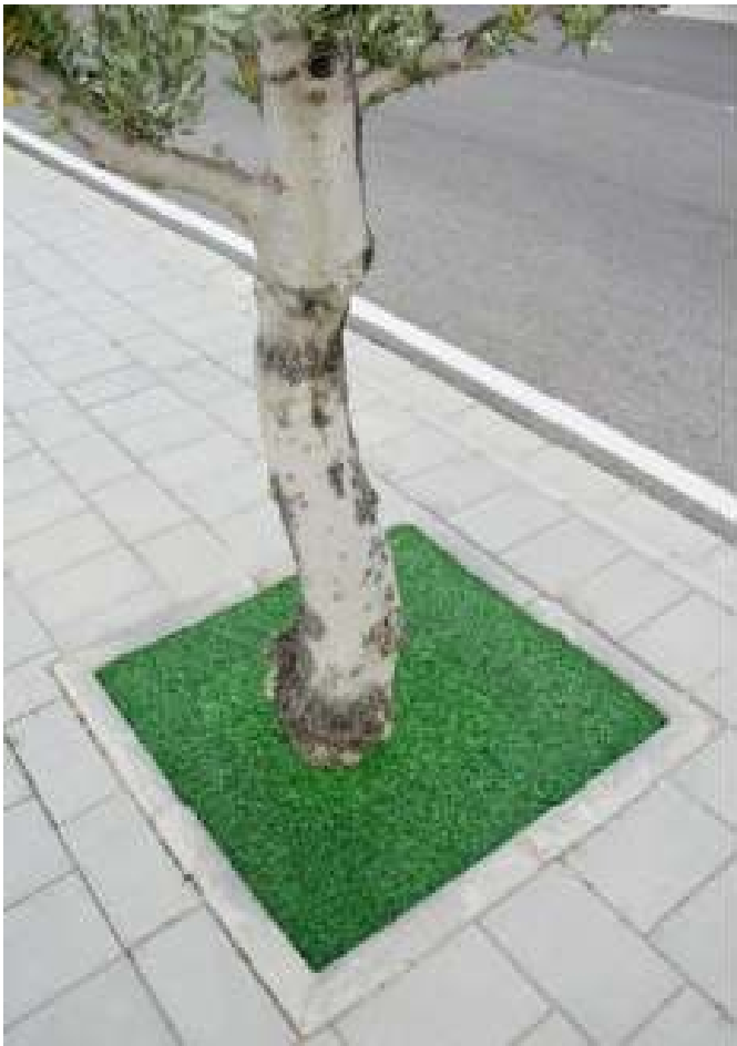
DETALLE ALCORQUE DRENANTE
