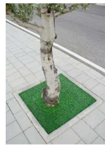
DETALLE ALCORQUE DRENANTE
