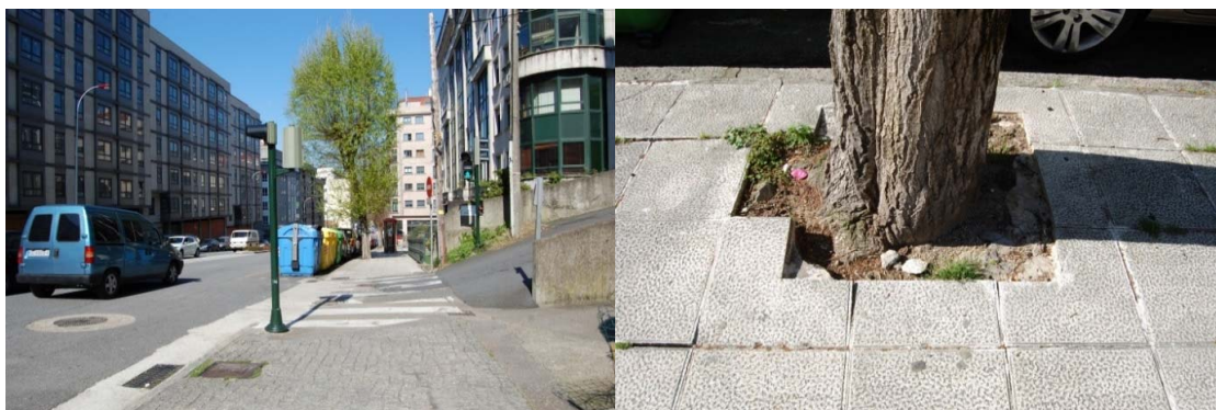
Figura 5. Imagen de paso de peatones sin pavimento previo que indique dicha situación y alcorque sin ningún tipo de elemento que indique la presencia del árbol y evite el desnivel entre el pavimento y el terreno.
