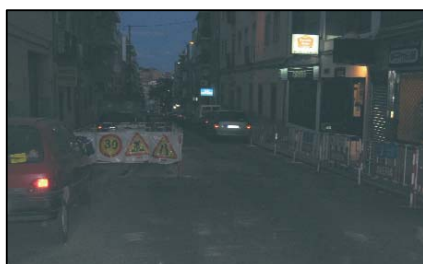
Señalización de obra, señales NO Reflectantes
