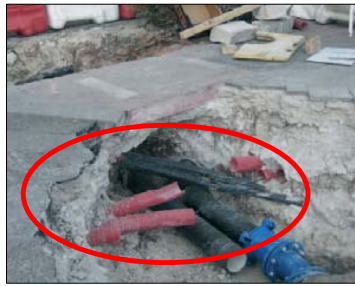
Rotura de los conductos de protección
