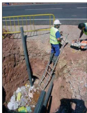
Acceso a zanja mediante escaleras
