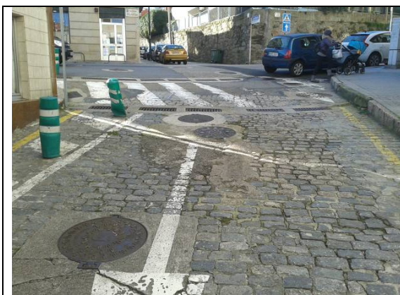
Deficiencias en la pavimentación con hundimientos en la zona adoquinada.
