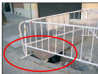
Apoyo inestable de la chapa
