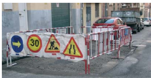
Vallado y señalización de zona de trabajo
