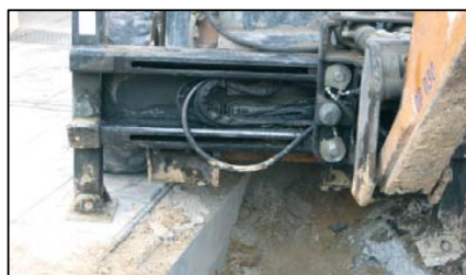
Apoyo sobre dos superficies de diferentes resistencias.
