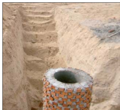
Acceso a zanjias mediante escalera realizada en el propio terreno
