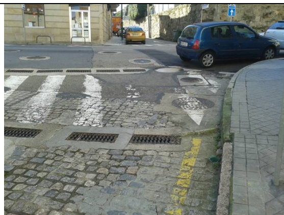
Estado de la pavimentación y paso de peatones existente.
