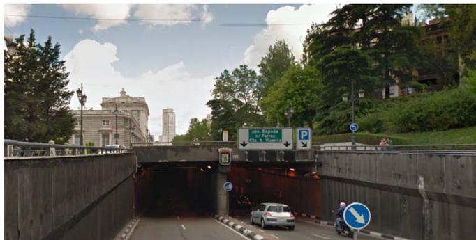
**FOTOG. 2** Túnel urbano de la calle Bailén en Madrid; resuelve la transición peatonal entre el Palacio Real, y la plaza de Oriente. Tiene un gálibo de 4,00 metros y es un túnel corto, con una amplia sección urbana.
