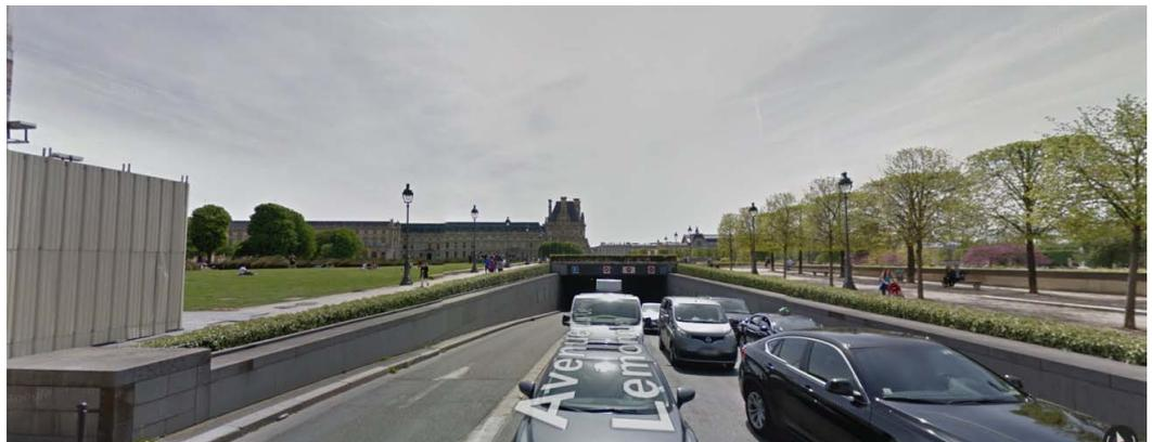
**FOTOG. 1** Túnel urbano en París, en la Avda del General Lemonnier; resuelve la transversal entre los Jardines del Louvre, y el Jardin de las Tuileries. Incluye el acceso a un parking. Es un túnel corto en alineación recta, con rampas de acceso pronunciadas.
