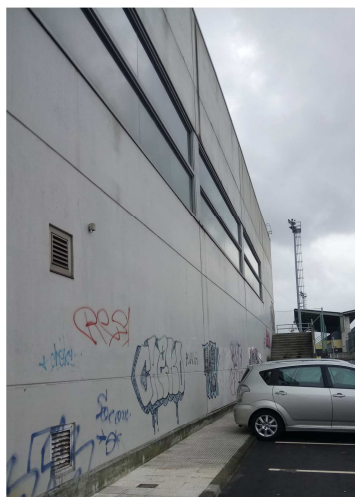
Cerramiento posterior del Polideportivo
