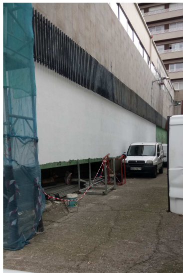
Visibilidad desde callejón de carga y descarga del mercado
