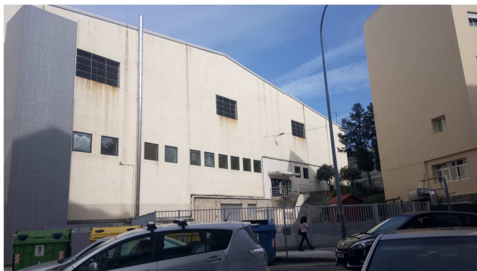
Vista general de cerramiento
