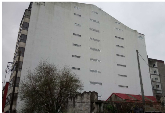
Vista general de la medianera
