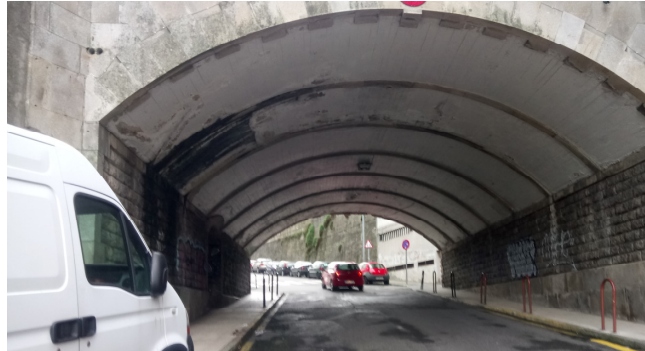
Vista general del túnel
