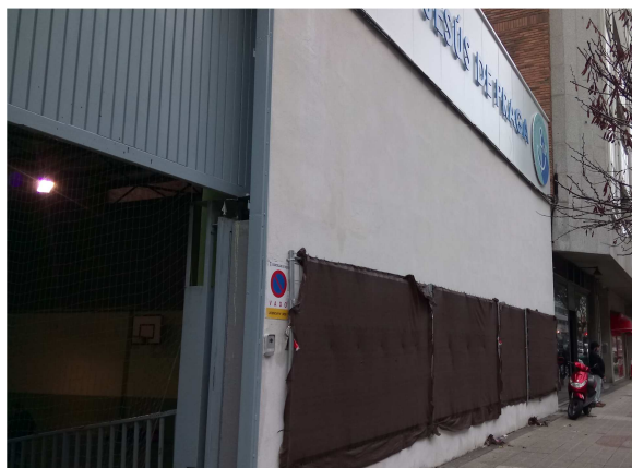
Vista del cerramiento desde c/ Rosalía de Castro
