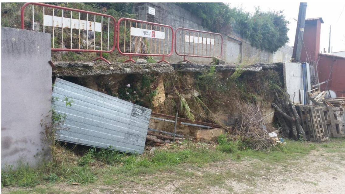
También se puede observar que los medios de cubrición de los laterales son insuficientes para contener el empuje del terreno cuando este se produce por lo que se decide diseñar un muro que ocupe toda la longitud del talud en el tramo.
