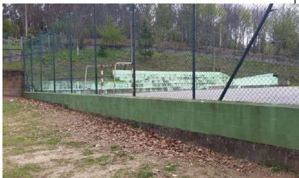
Cerramiento interior de la pista deportiva
