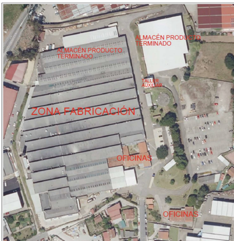
Fig. Vista aérea da planta
